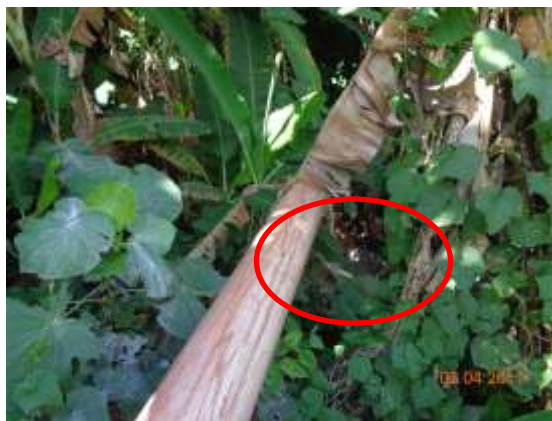
Foto 14. Lançamento de esgoto no fundo de residência
