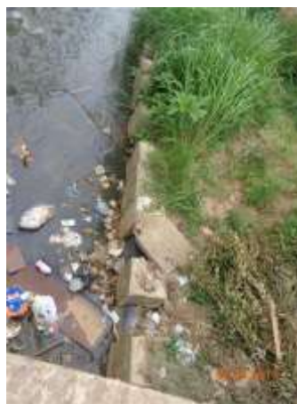
Foto 6. Acumulo de resíduos sólidos nas ancoragens
