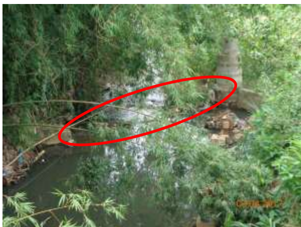
Foto 5. Remanso provocado por travessia do interceptor
