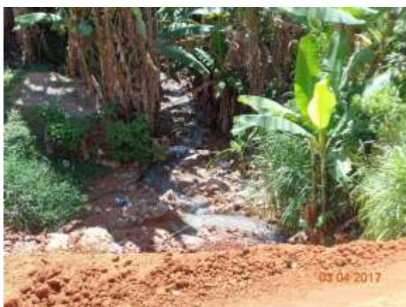
Foto 7. Lançamento de esgoto no fundo de
