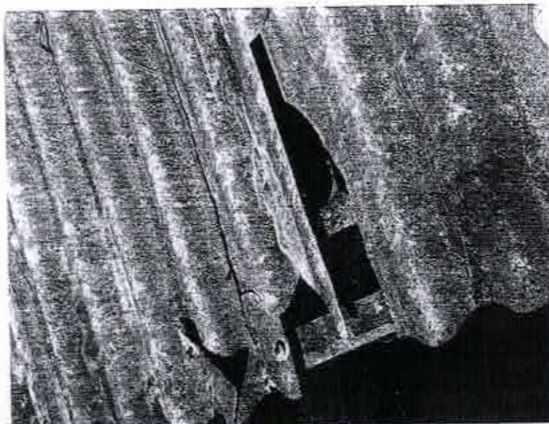
FOTO 01-TELHAS QUEBRADAS
