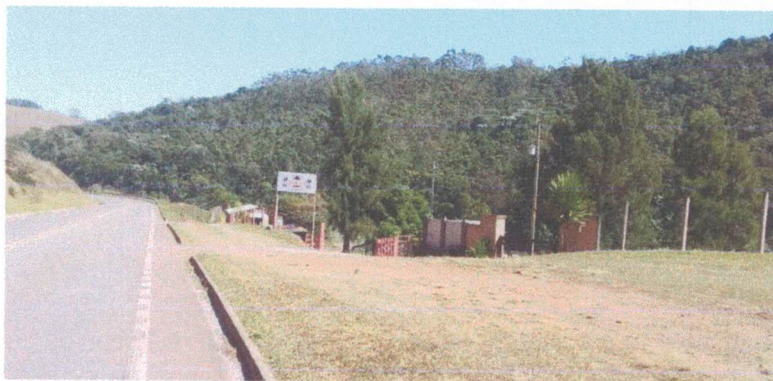
Fotos da localidade sem iluminação pública.
