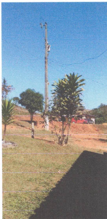
Fotos da localidade sem iluminação pública.
